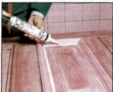
Наружные двери подвержены частым перепадам температуры и, соответственно, сжатию и расширению. Здесь подойдет эластичный акриловый состав для заделки швов.
