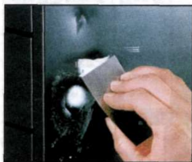
Металлические поверхности требуют особой подготовки. Соответствующая шпатлевка не должна давать усадку при высыхании.
