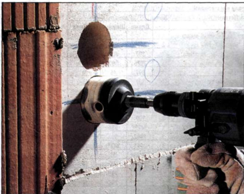
С помощью кольцевой буровой коронки можно и в твердой бетонной стене сделать глухое отверстие под выключатель или розетку для скрытой электропроводки.
