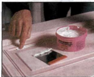
Мелкие трещинки перед нанесением подслоя следует закрыть тонкой шпатлевкой. В углы ее лучше всего втирать смоченным в воде пальцем.
