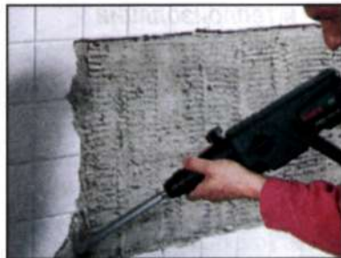
Плоским долотом без труда можно сбить старую плитку, выбрать канавку под электропроводку, а также сбить небольшие неровности.
