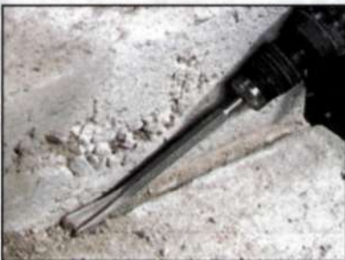
Канавку под электропроводку выбирают желобчатым долотом ( \varnothing 22 \times 250 мм). Хвостовик SDS-plus облегчает смену инструмента в патроне перфоратора.
